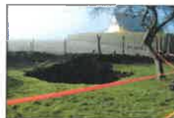
Mouvement de terrain (cavités souterraines)
